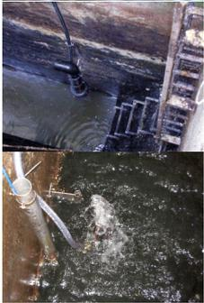
**Beispiele für die Installation und den Betrieb von Wälzbelüfter-Systemen sowie die Beimpfung mit AQUA**
